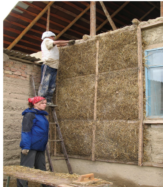
Abbildung 3: Isolation eines Hauses in Jergetal (Gebiet Naryn), 2300 m über N.N.
