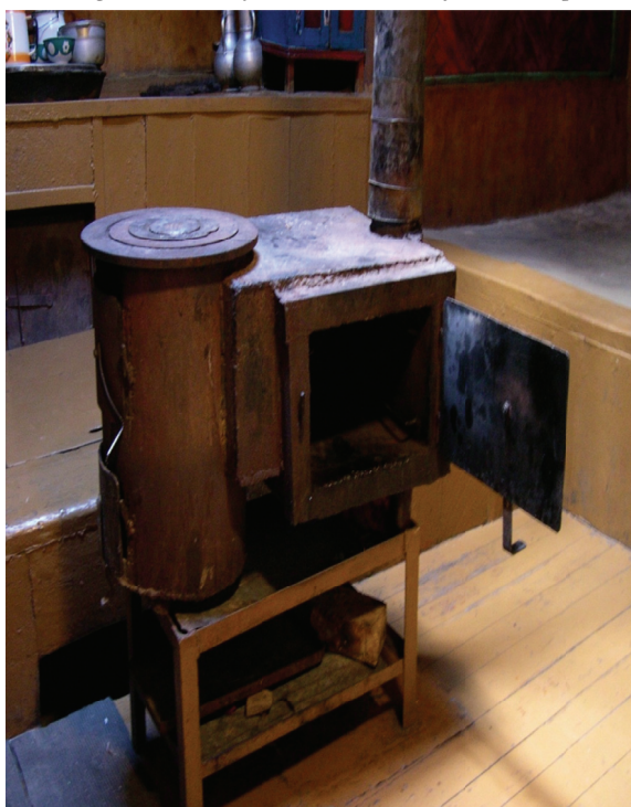
Abbildung 1: Aus der Sowjetzeit stammender Ofen aus Stahlplatten
